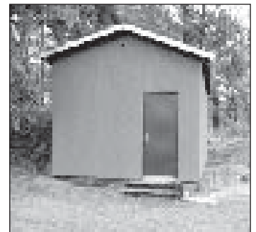
Toimub Väimela, Kose, Parksepa ja Puiga pumbajaamade puhastusseadmete rekonstrueerimine (filtrite, hüdrofooride, pumpade vahetus, pumbajaamade ümberehitamine kaheastmelisteks). Tööde maksumus 2 383 187 krooni. Fotol Puiga pumbajaam. Tööde lõpp septembrikuus
