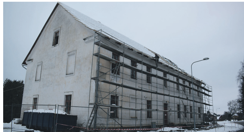
Üürimaja ehitustööd Vastseliinas. Foto: Anneli Lõhmus
