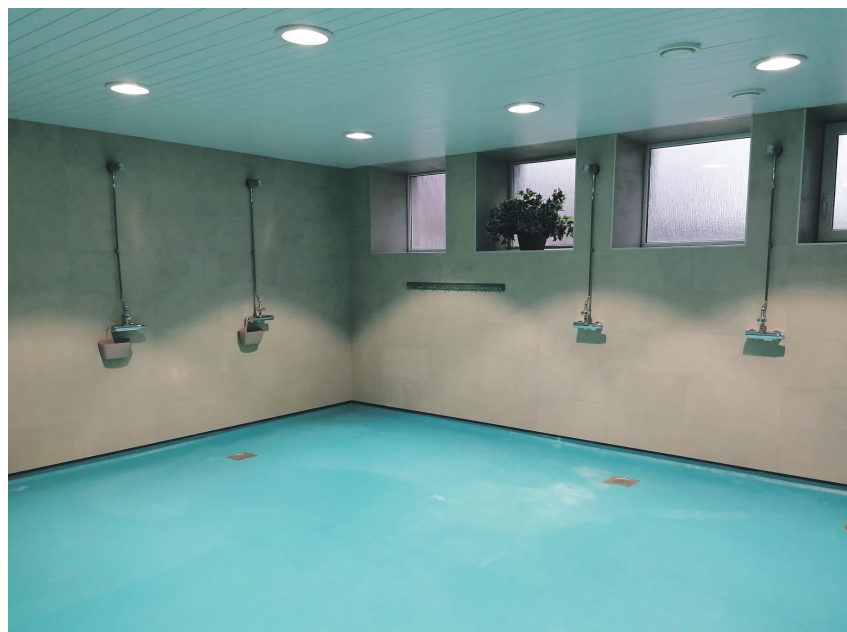
Väimela tervisekeskuse rekonstrueerimistööde käigus remonditi ka pesuruumi. Foto: Henn Antson
